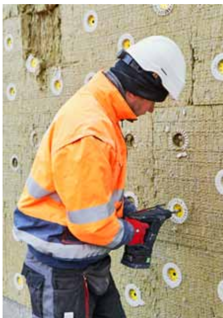
Abb. 6: Nach dem Abstreifen der Separations- und Putzschicht werden die Dübelrondellen und Dübel rückgebaut.
