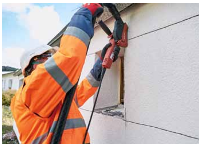
Abb. 5: Beim Rückbau wird die Putzschicht zunächst mit der Mauernutfräse rasterförmig aufgeschnitten.
