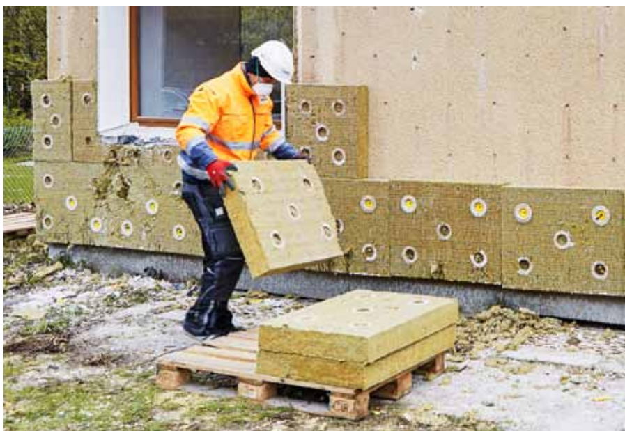
Abb. 7: Schließlich können die Mineralwolle-Dämmplatten manuell und rückstandsfrei entfernt werden.
