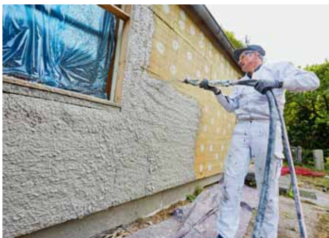
Abb. 4: Eine Separationsschicht aus mineralischem Grundputz und Gewebe egalisiert Unebenheiten und sorgt dafür, dass die Putzschicht beim Rückbau sauber von der Dämmplatte getrennt werden kann.
