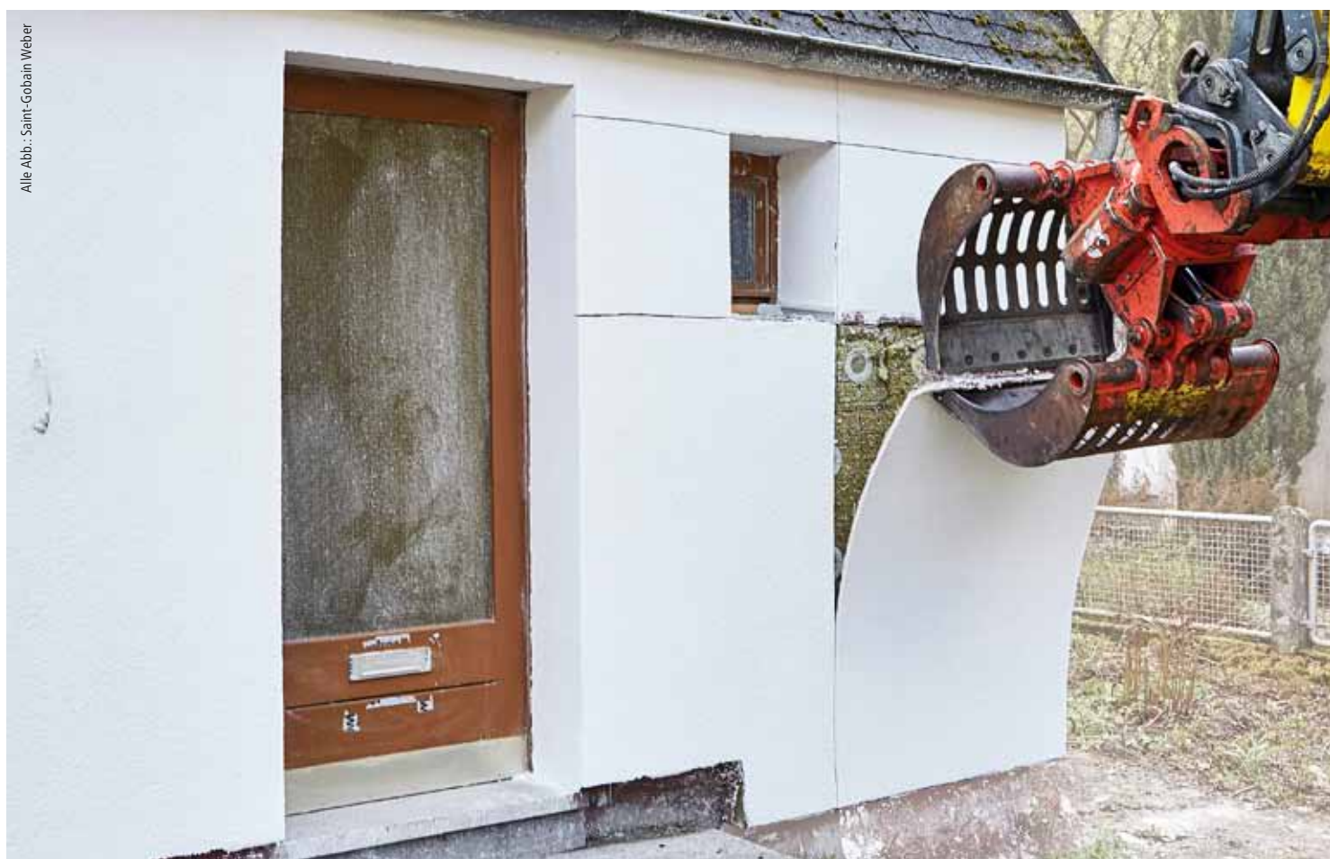
Abb. 1: Das neue WDVS von Saint-Gobain Weber lässt sich sortenrein zurückbauen. Hier zieht der Greifarm des Baggers das integrierte Separationsgewebe bahnenweise mitsamt der Putzschicht ab. Der Putz wird dann mechanisch vom Gewebe getrennt.
