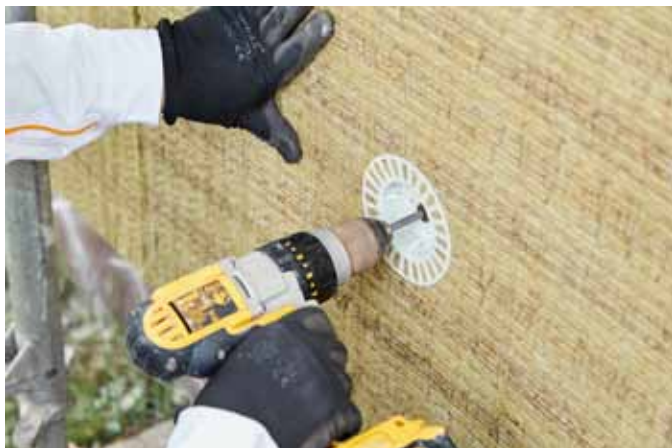
Abb. 2: Die Dämmplatten werden rein mechanisch mit Schraubdübeln an der Fassade befestigt.
