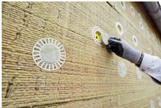
Abb. 3: Die versenkte Dübelmontage mit Mineralwoll-Rondellen verhindert Wärmeverluste.
